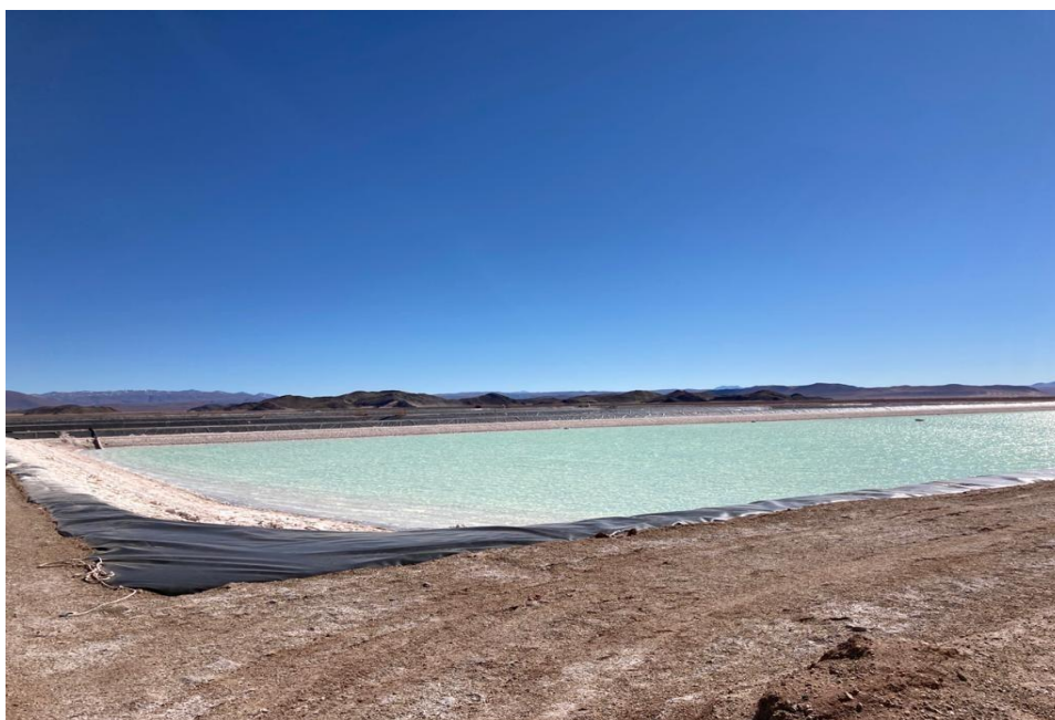
Figura 1: Pileta de evaporación en SHM, Antofagasta de la Sierra, Catamarca. Imagen facilitada por asamblea PUCARA
